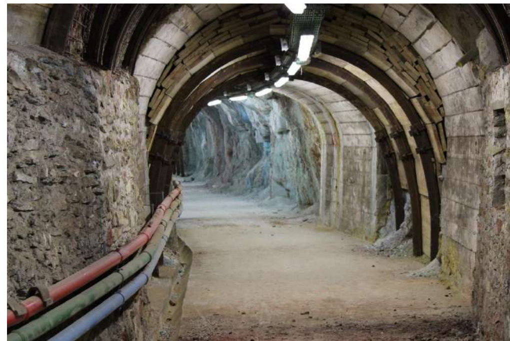
Galería do piso 30 de Algares
